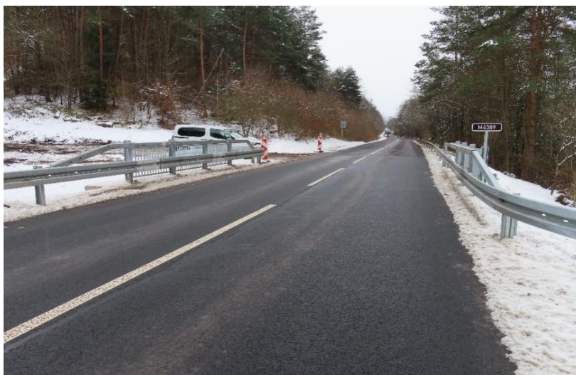
Most M4389, evid. č. 591-009, po realizácii
