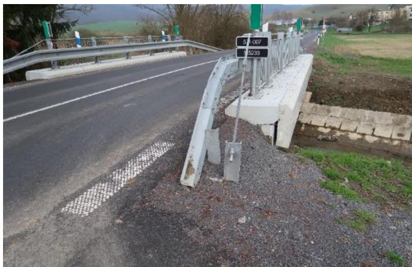
Most M2930, evid. č. 571-012, po realizácii
