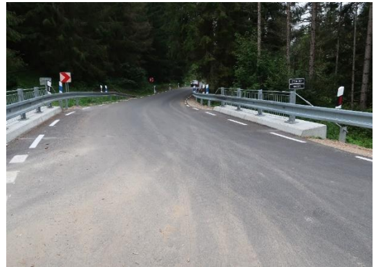
Most M4301, evid. č. 2724-007, po realizácii
