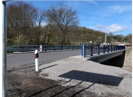
Most M3561, evid. č. 591-005, po realizácii
