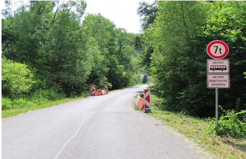
M886 , evid. č. 2492-1B_ Most cez Ihráčsky potok v km 4,100 Trnavá Hora – osadené DDZ
